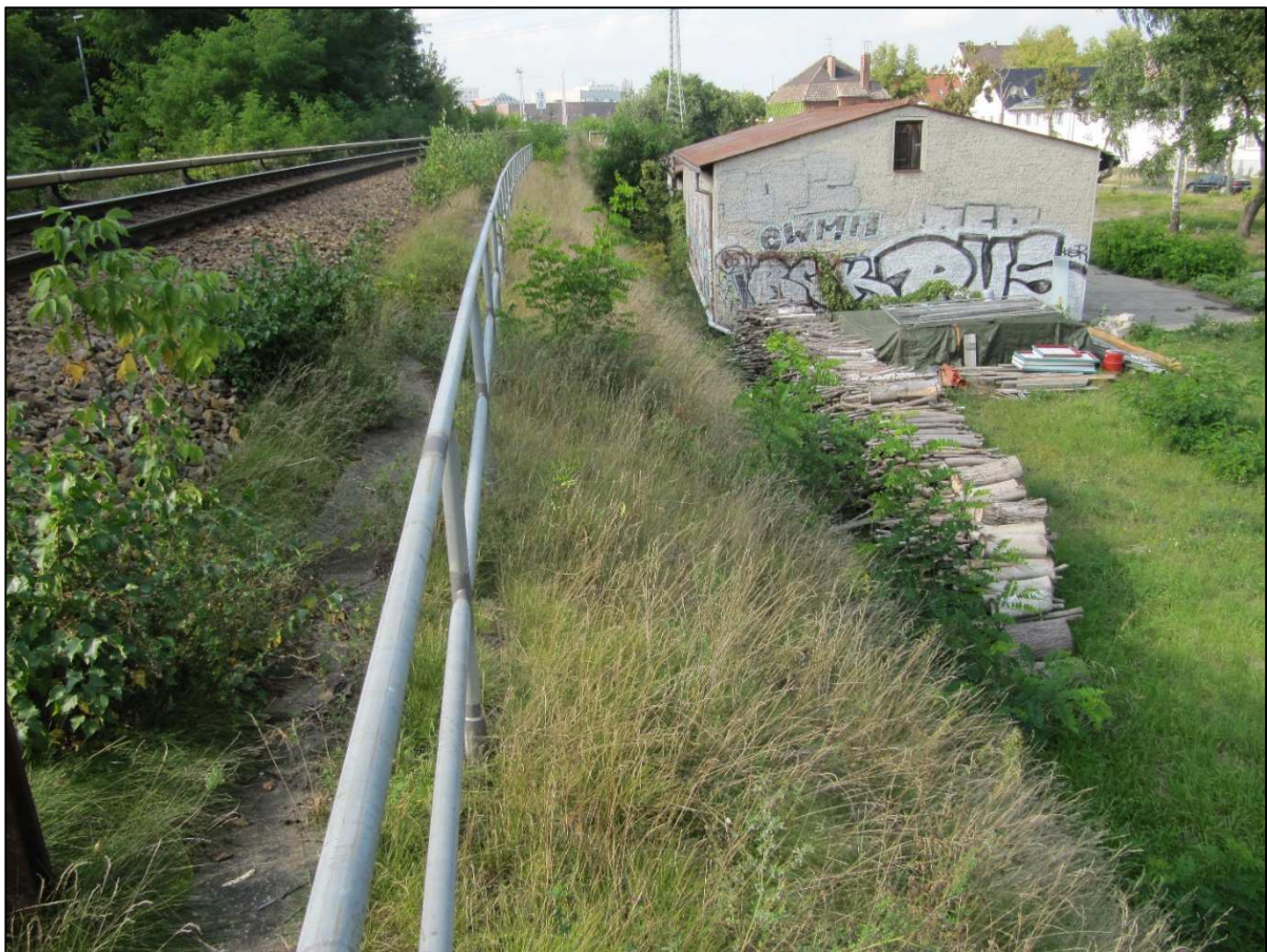
Bild 2: Zustand der Stützkonstruktion im September 2012
