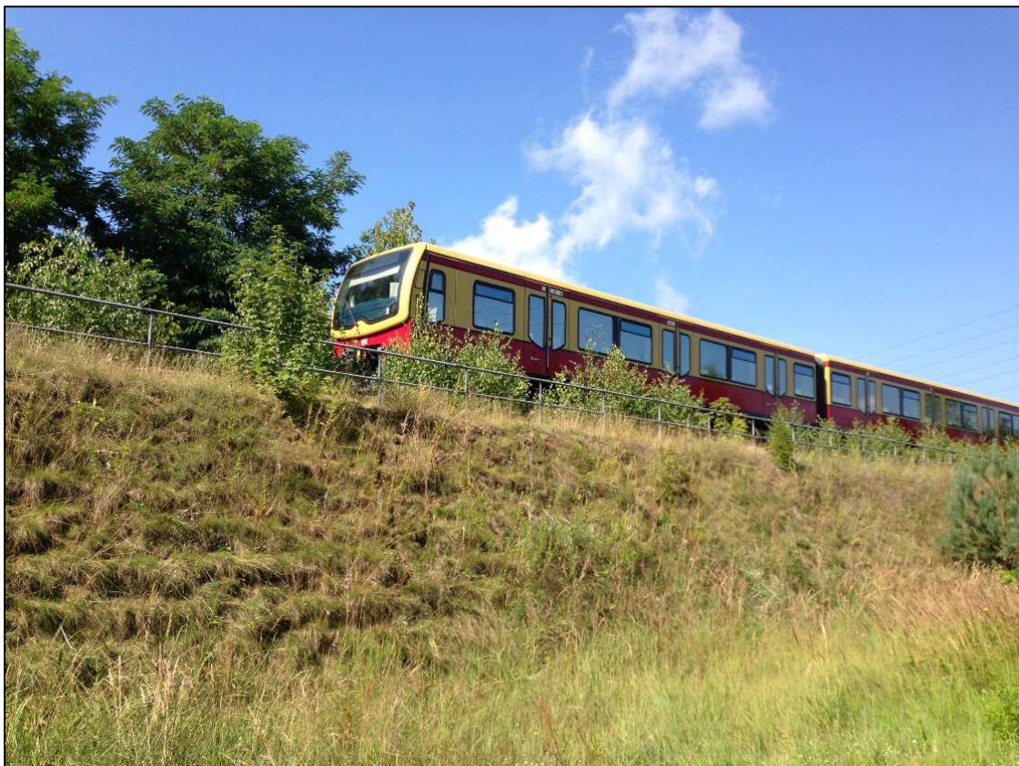
Bild 5: Zustand der Stützkonstruktion August 2013
