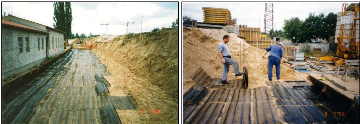
Bild 1a und 1b: Einbau der einaxialen Geogitter Tensar SR 80 Juli 1998
